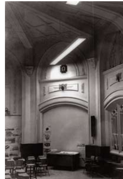
La chapelle de la Faculté de l'aménagement transformée en salle de cours, 1973. (Photo : UdeM)
