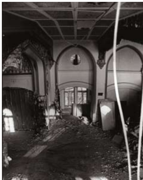
Démolition de la chapelle en 1996. (Photo : Roger Thibault)
